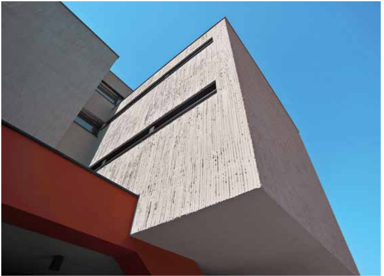
Wo einst Sichtbeton dominierte, interpretieren nach der Sanierung expressive Putzstrukturen und zarte Farben die ursprüngliche Rohheit neu.
