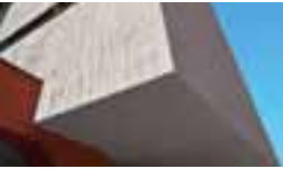
6 Extremputz über Sichtbeton Primarschule Krauer in Kriens
