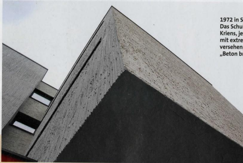
1972 in Sichtbeton gebaut: Das Schulhaus Krauer in Kriens, jetzt gedämmt und mit extremen Putzstrukturen versehen, die den ehemaligen „Beton brut“ aufnehmen.
