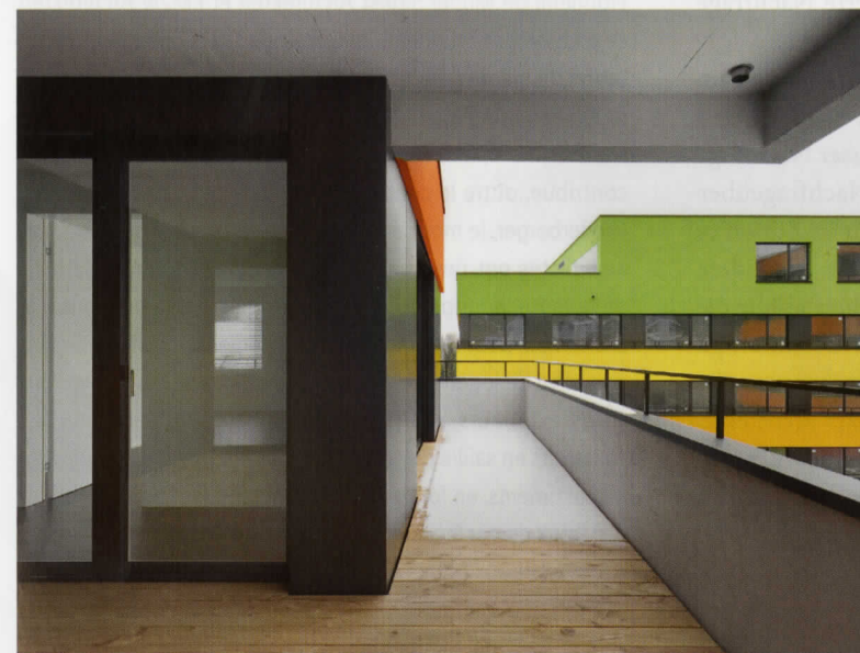
Geschützter Loggiabereich und offener Balkon
